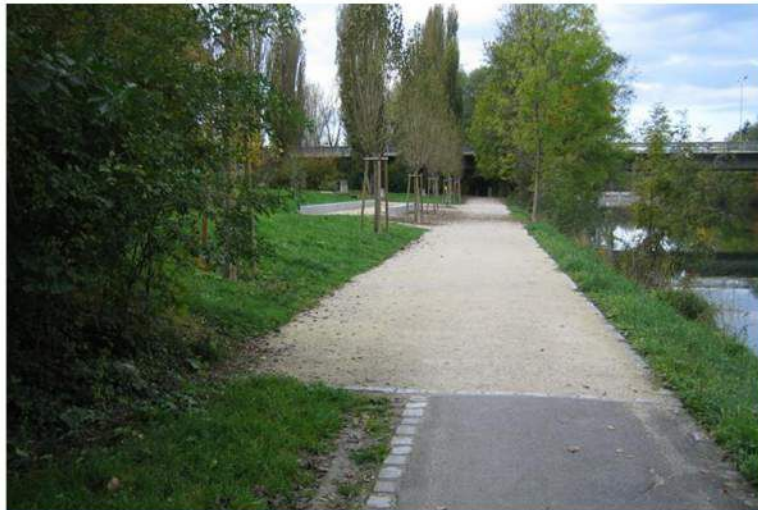
Vorher ein schmaler asphaltierter, nacher ein breiter chaussierter Weg. Abschnitt im Bereich Wasserversorgung Zürich.
