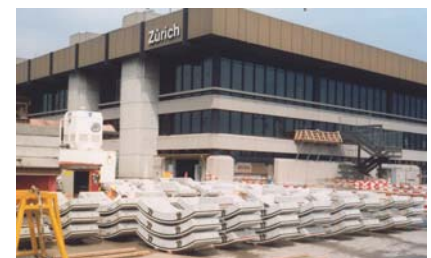
Zwischendeponie am Flughafen
