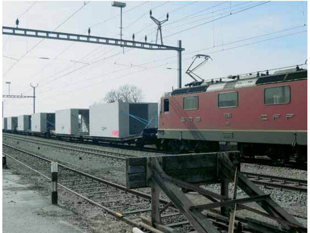
Ein Hotel kommt per Bahn. Die Module bei der Auslieferung Bahnhof Avenches.
