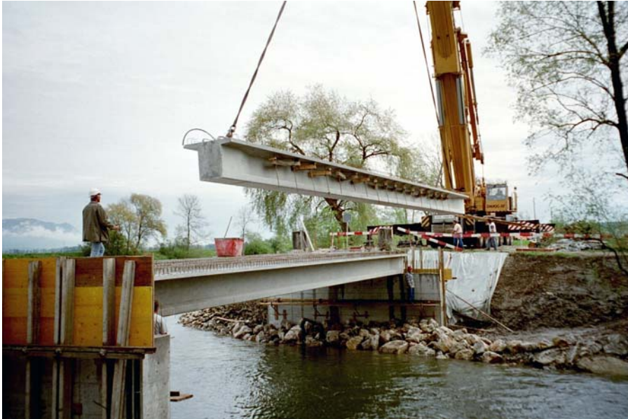
Montage der Träger mit einem 220to Kran vom Widerlager aus. Montagedauer: 1 Tag
