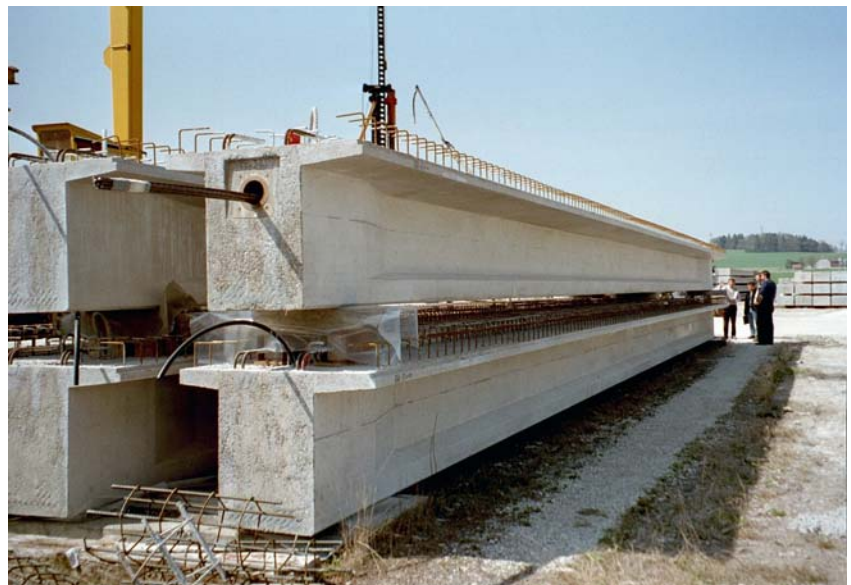
Träger auf dem Lagerplatz. Gut ersichtlich ist das eingelegte Vorspannkabel.
