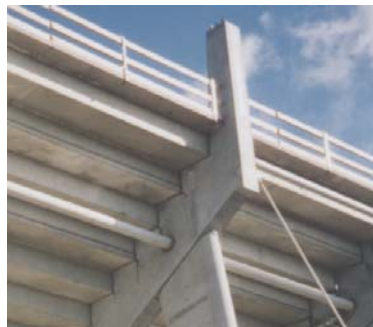
Verbindung Sägeträger mit hinterer Betonstütze
