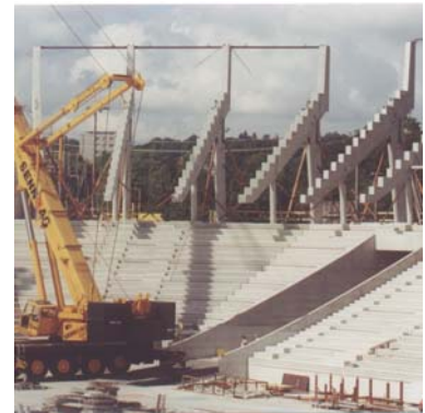
Montage Sägezahnträger
