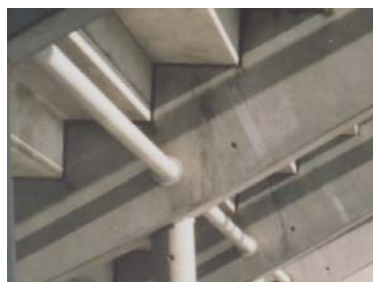
Verbindung Sägeträger mit Stahl-Mittelstütze
