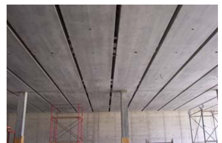
Untersicht Decke im Rohbau
