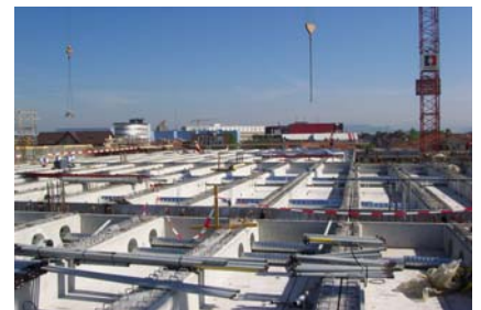
Montage mit 200 t Pneu Kran
