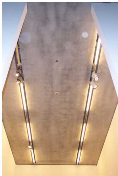
Untersicht Decke fertig mit integrierter Beleuchtung
