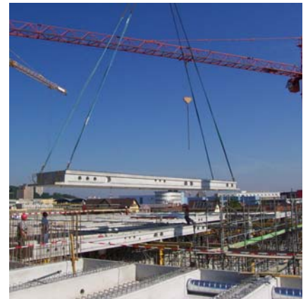
Montage mit 200 t Pneu Kran
