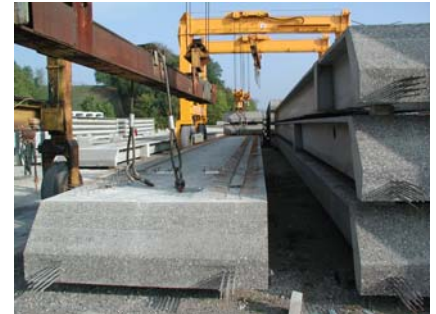
Portalkrane holen die Rippenplatten vom Lagerplatz
