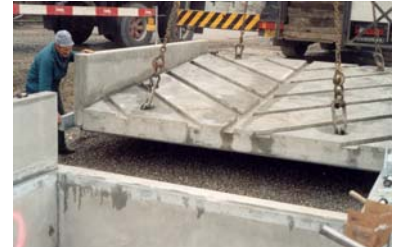
Montage der Schleppplatte
