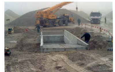
Fertige Wanne mit einer Schleppplatte
